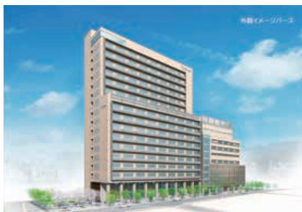
新設中の高松駅キャンパス(外観イメージ)
